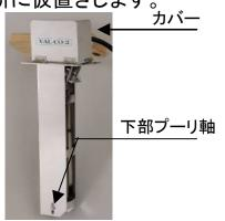
④SUSベルトの交換 モータプーリより古いSUSベルトを を取外し、新しいベルトと交換します。
